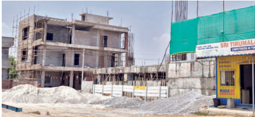
చిలుకూరు రెవెన్యూ టీజాపూర్ రహదారికి ఆనుకుని ఆండర్గ్రౌండ్ తవ్వి మరి నిర్మాణాలు చేపడుతున్న దృశ్యం
